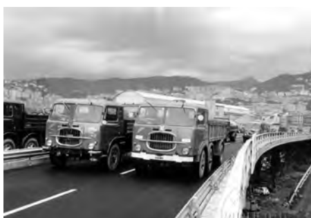
Il collaudo della sopraelevata fu effettuato nel 1965 con l'ausilio di due colonne di autocarri zavorrati (Archivio Publifoto Genova)
